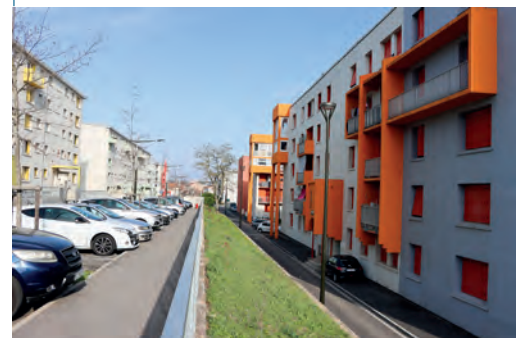
La Conte. Face au lycée Jules-Fil, la rue Diderot requalifiée, avec nouvel éclairage public écologique, arbres, ralentisseurs... devient une artère principale du quartier qui s'ouvre ainsi sur la ville.
